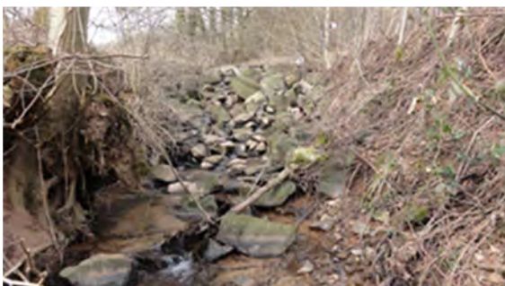
Anrampung aus Basaltblöcken im Fahrbachtal zum Zeitpunkt der Erstellung des PEPL (2011)
