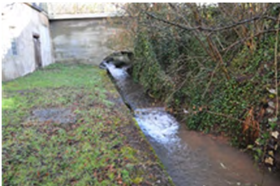
Abschnitt des Brückendurchlasses am unteren Mühlbach
