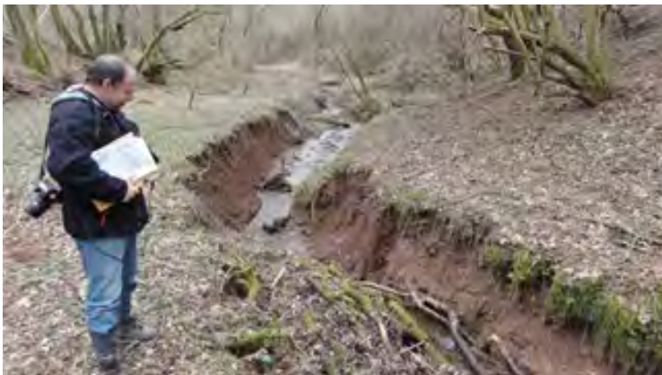
Typische, nicht unnatürliche Ausbildung einer Erosionsstrecke am Fahrbach; Die Profilübertiefung durch Sohlenerosion ist bei diesem Gewässertyp ein natürlicher Prozess
