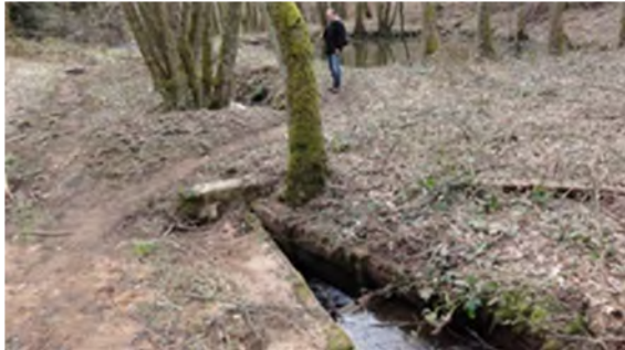
Ausgangssituation im Bereich der Maßnahmenstrecke E „Teichanlagen“ am Fahrbach ( bachabwärts)
