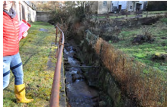
Ausgebauter 80m langer Mühlbachabschnitt mit Abstürzen
