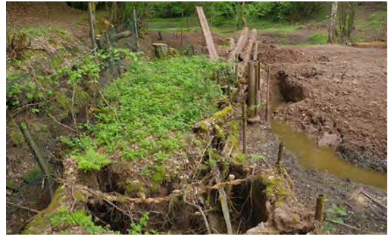
Rückbau der stark befestigten Teichufer und der Uferverbauungen des Fahrbachs
